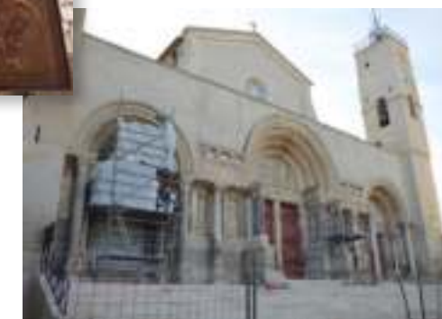
Restauration de l'abbatiale Saint-Gilles
